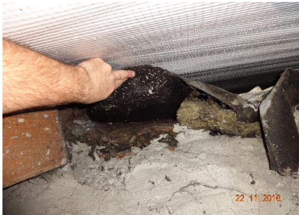
Wełna 5cm na poddaszu nieużytkowym bud A
