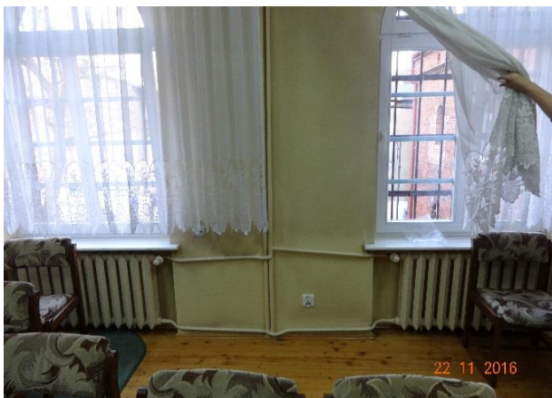
Grzejniki i rury CO prowadzone po wierzchu
