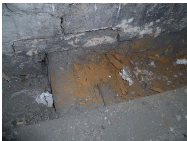
Budynek „A” – poddasze – porażona belka stropu
