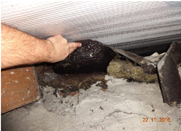
Wełna 5cm na poddaszu nieużytkowym bud A
