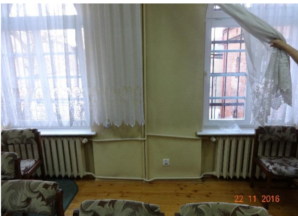
Grzejniki i rury CO prowadzone po wierzchu
