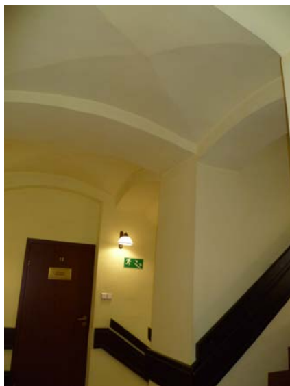
Budynek „A” – sklepienia klatki w parterze
