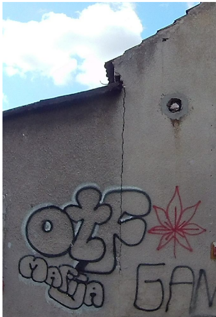
9. Uszkodzenia powłoki tynk.
