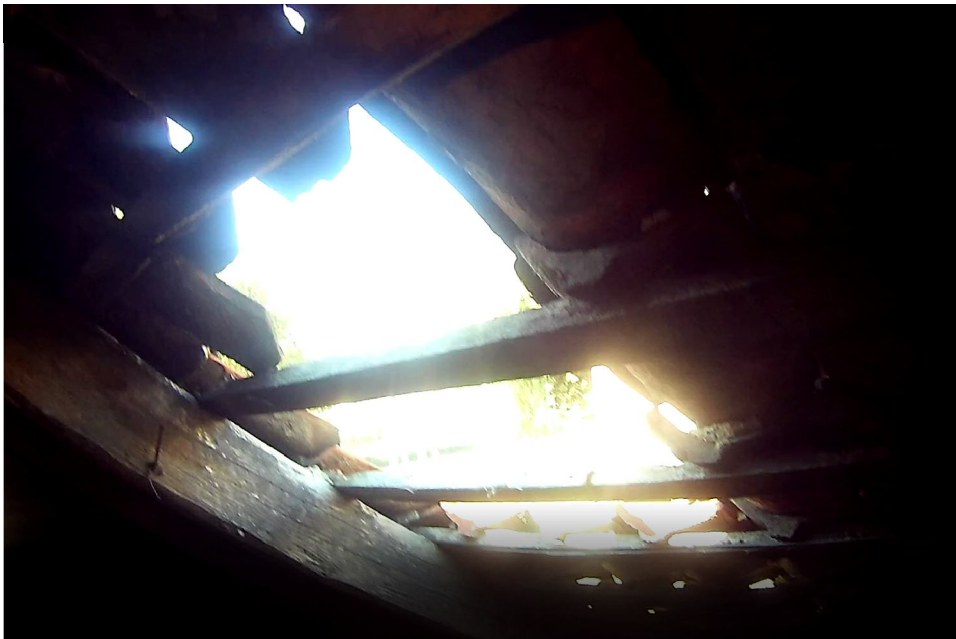
15. Niekompletne pokrycie dachowe
