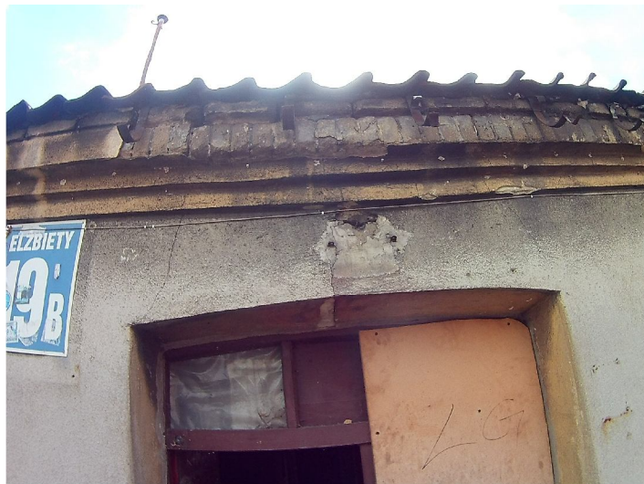
4. Spękania przy nadprożu drzwi wejściowych
