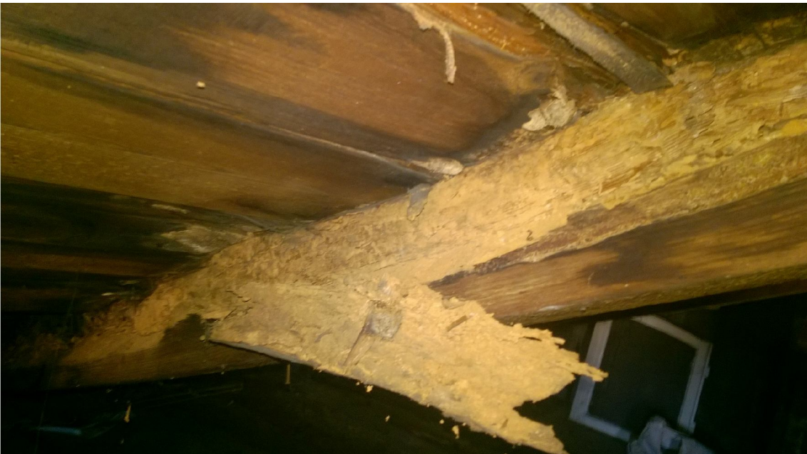
13. Wysypywanie się pyłu zniszczonej bieli el. drewnianych
