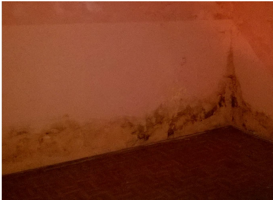
7. Zawilgocenie ścian parteru
