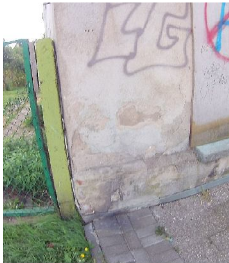
1. Zawilgocenie ściany zewnętrz.
