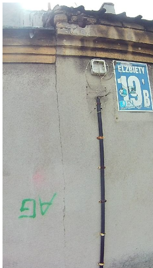
3. Spękanie ściany zewnętrznej
