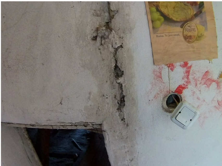
16. Efekty działania wody dostającej się przez niekompletne pokrycie dachowe
