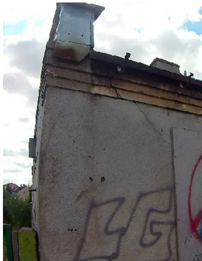
2. Spękanie ściany zewnętrznej niekompletne orynnowanie
