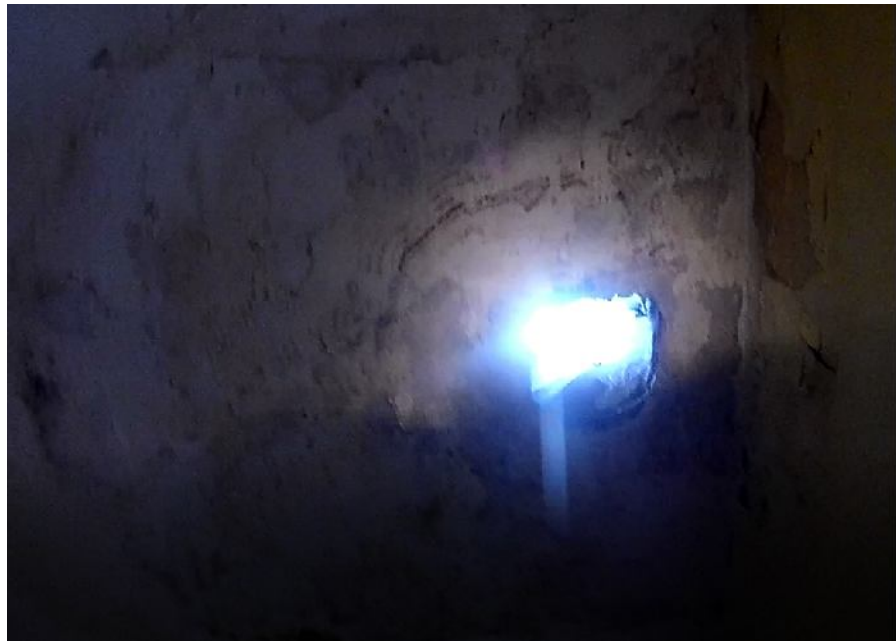
8. Dziura w stropie i efekty działania dostającej się do bud. wody
