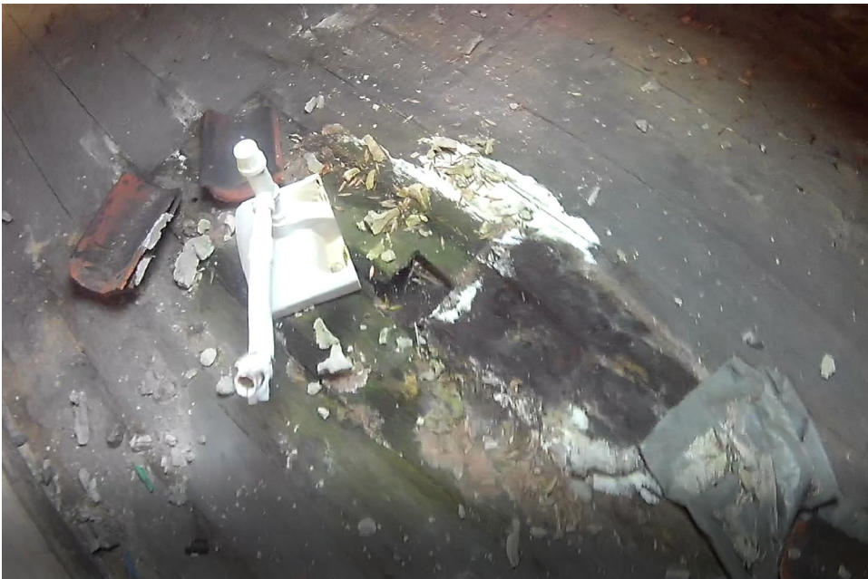
16. Efekty działania wody dostającej się przez niekompletne pokrycie dachowe
