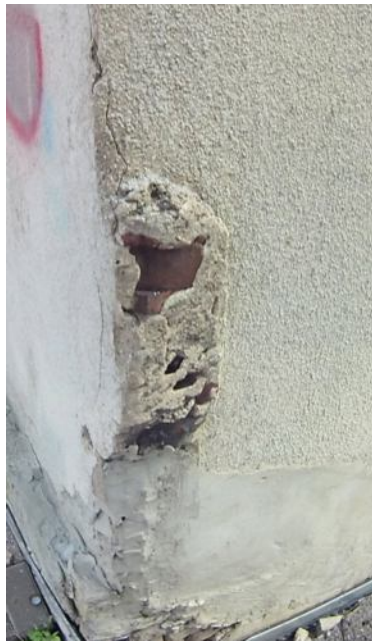
6. Spękanie ściany w narożniku bud.
