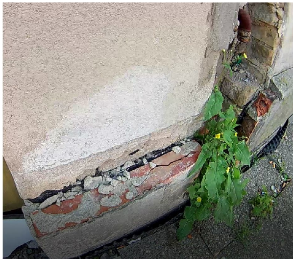
5. Uszkodzenia partii cokołowej budynku
