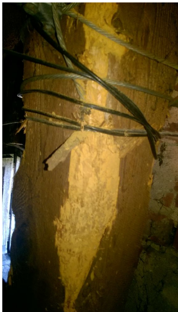
16. Efekty działania wody dostającej się przez niekompletne pokrycie dachowe
