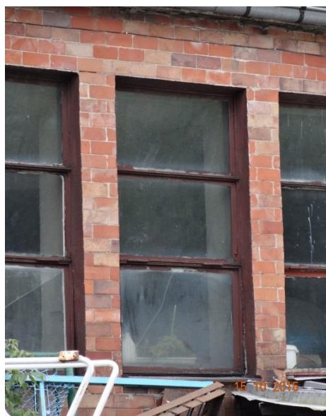
okna metalowe stacji uzdatniania wody- do wymiany
