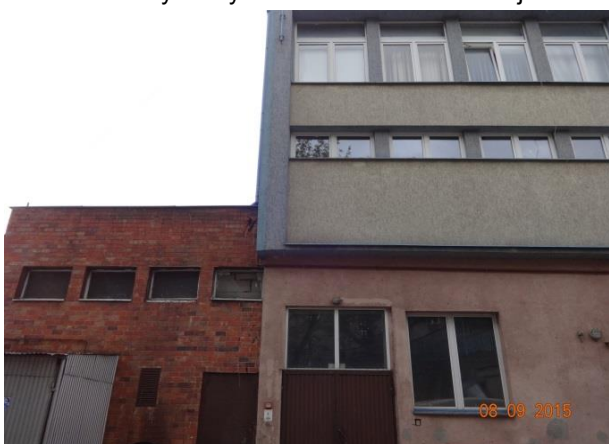
u dołu południowo- wschodnia ściana kotłowni z drzwiami do wymiany oraz oknami do likwidacji
