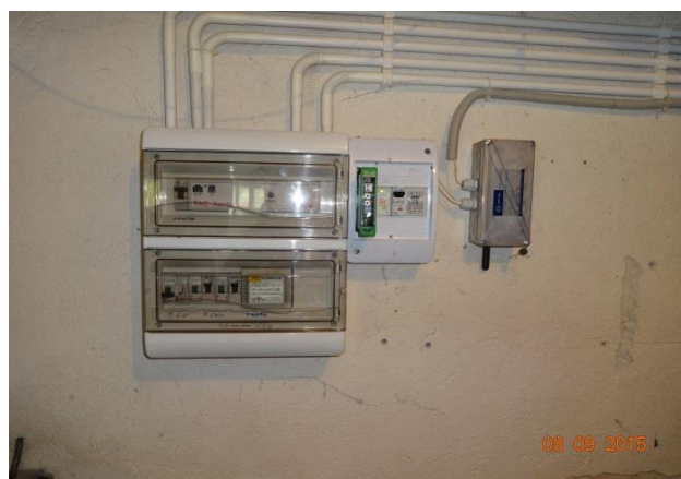
włączniki pomp obiegowych i cyrkulacyjnej CWU
