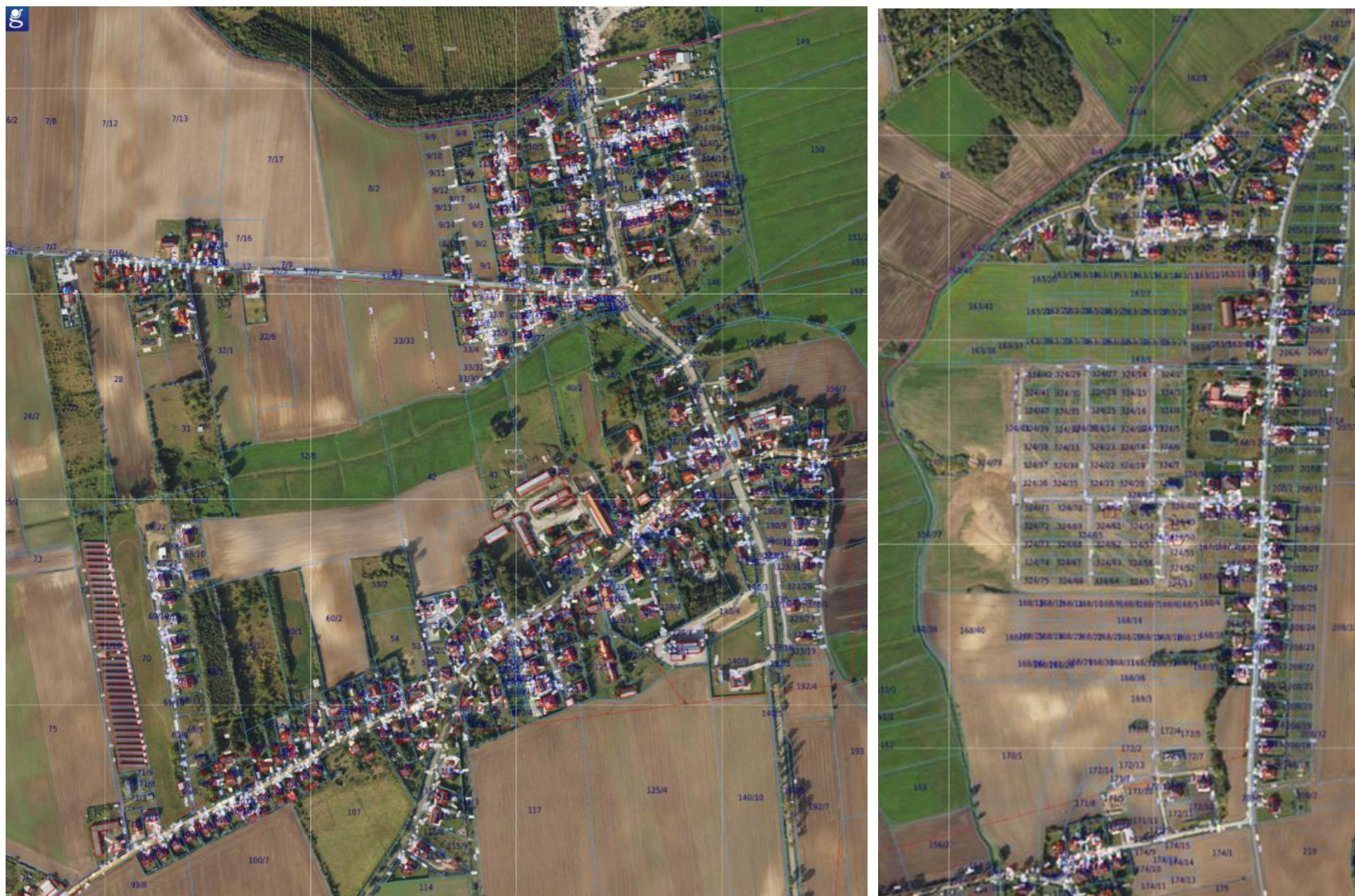
Ryc. 82. Wizualizacja sytuacyjna zabudowy oraz zagęszczenie infrastruktury technicznej wzdłuż głównych ciągów komunikacyjnych Bałdowa. Źródło: geoportal.gov.pl.
