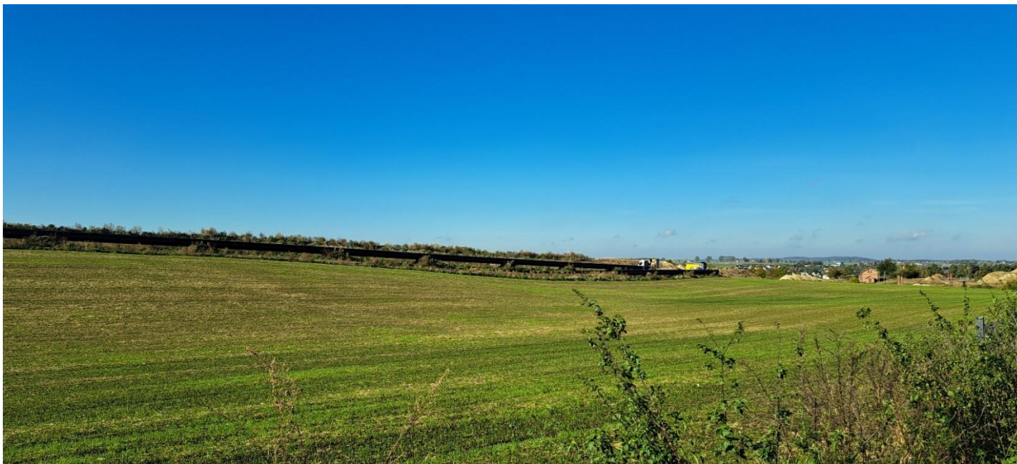
Ryc.11. Budowa magistrali gazowej po stronie północno-zachodniej Osiedla Nowe Rokitki. Źródło: zdjęcie własne autora.
