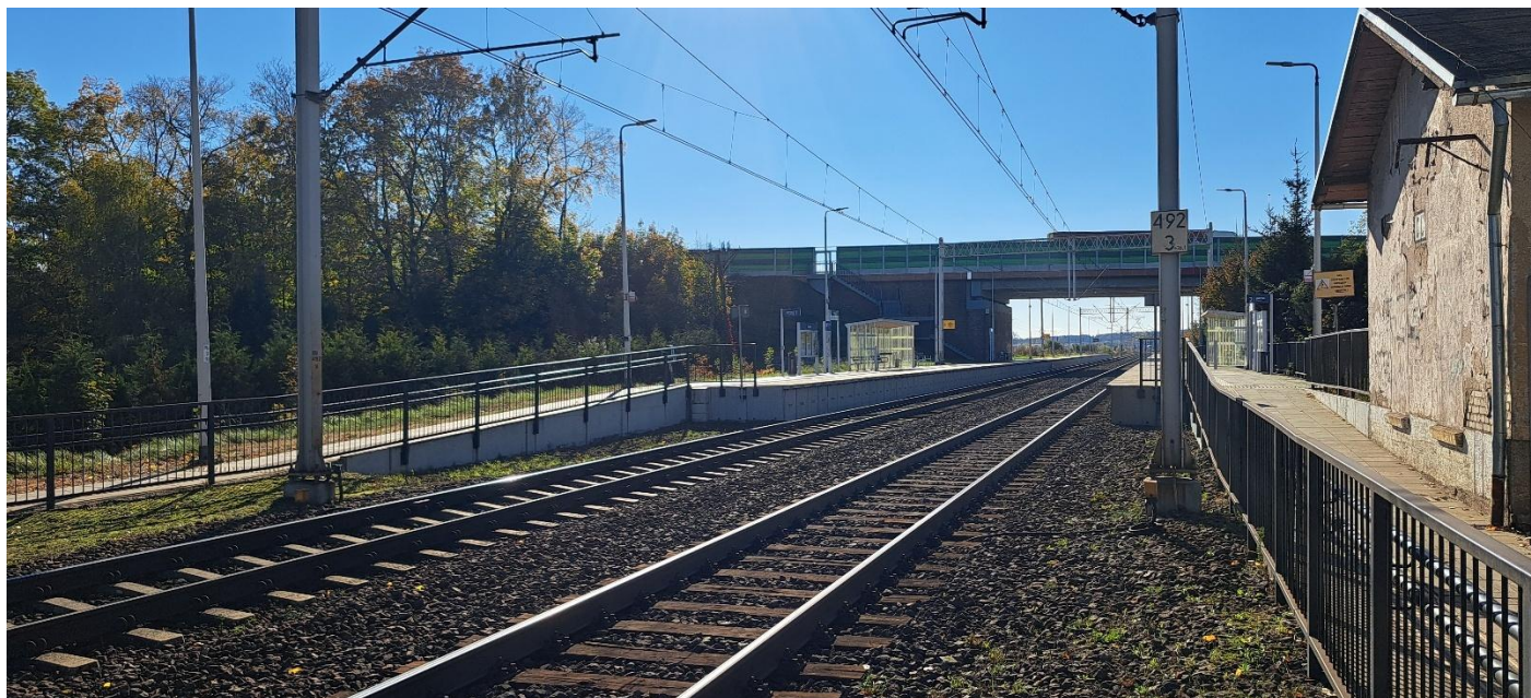
Ryc.16. Widok na przystanek Czarlin w kierunku Bydgoszczy i wiaduktu DK22. Źródło: zdjęcie własne autora.
