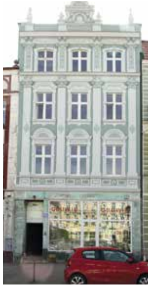
Kamienica przy pl. Hallera 15
