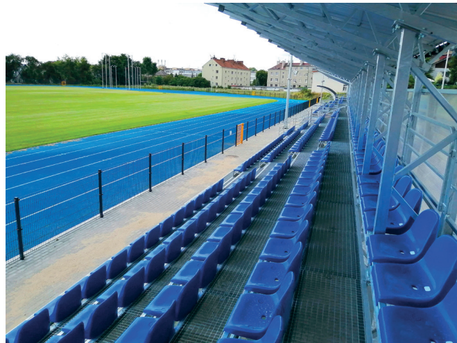
Kończy się realizacja II etapu budowy stadionu lekkoatletycznego. Trybuny pomieszczą 500 kubiców
