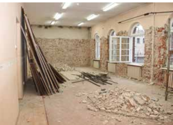
Zabytkowy budynek Miejskiej Biblioteki Publicznej zostanie gruntownie przebudowany
