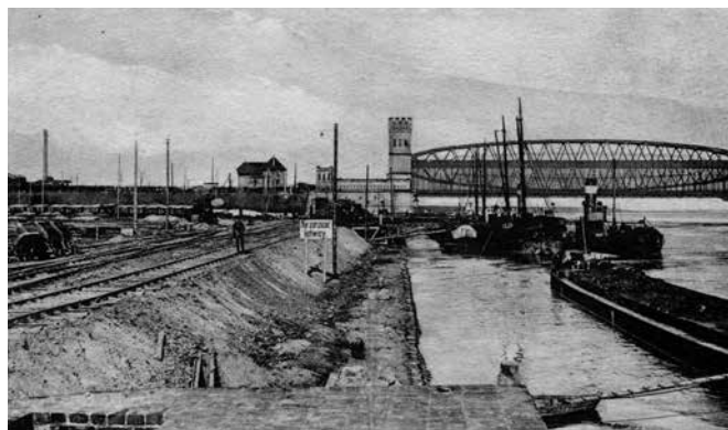
Budowa portu morskiego
