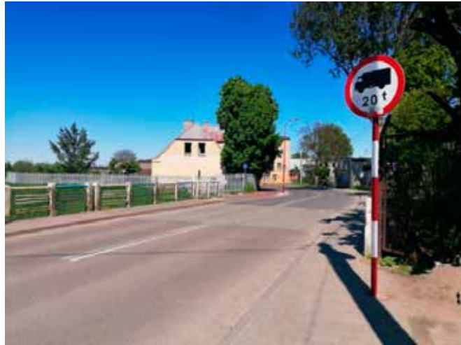
Trzeci etap inwestycji obejmuje m.in. przebudowę mostku przy ul. Łąkowej
