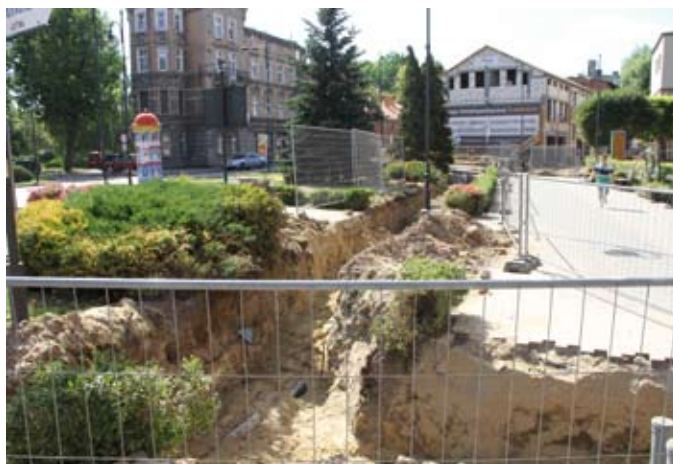
Prace przyłączeniowe potrwać do końca października
