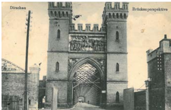
Portal zachodni obecnego mostu drogowego
