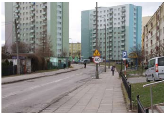
W tym roku zrealizowany zostanie II etap przebudowy ul. Jedności Narodu
