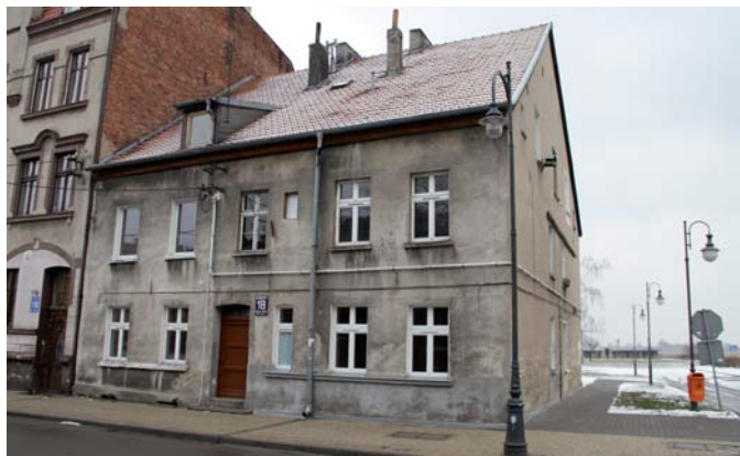
Budynek przy ul. Zamkowej 18 zostanie rozebrany, a następnie odtworzony
