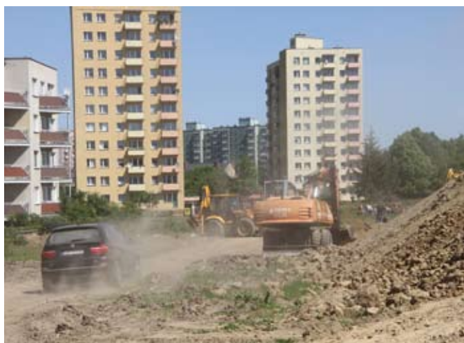
Przy tzw. ul. Nowosuchostrzyckiej trwają prace ziemne
