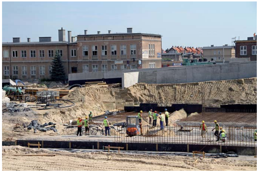
Teren przed dworcem PKP to wielki plac budowy
