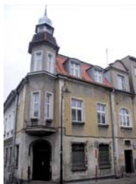
W budynku przy ul. Chopina 33 trwają ostatnie prace adaptacyjne.
