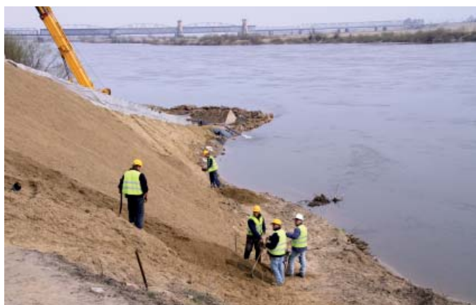
Trwają prace przy kształtowaniu nasypów
