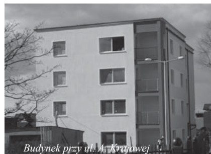
Budynek przy ul. A. Krajowej
